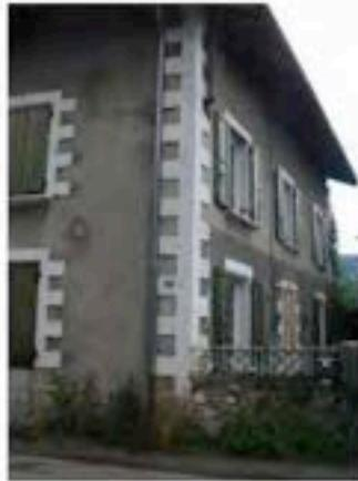
Détails : surlignage des angles et ouvertures, dépassé de toiture
